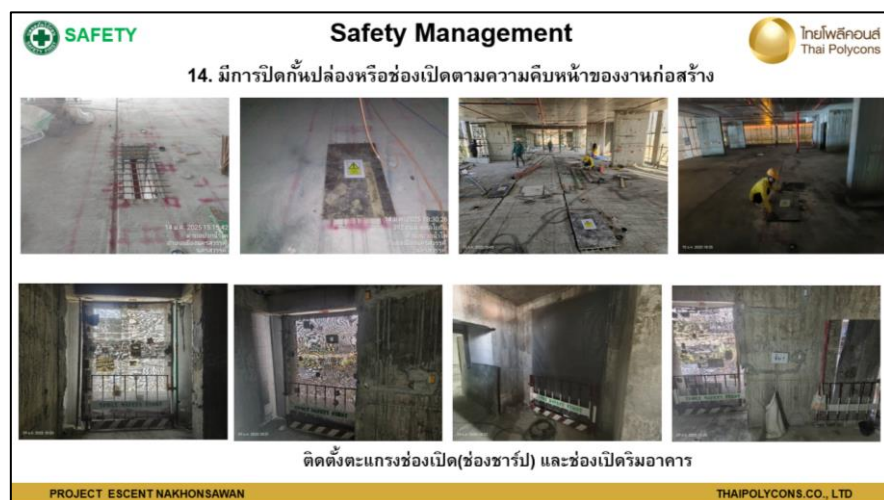
รูปที่ 44 การปิดช่องว่างต่างๆ ที่อาจก่อให้เกิดอันตราย
