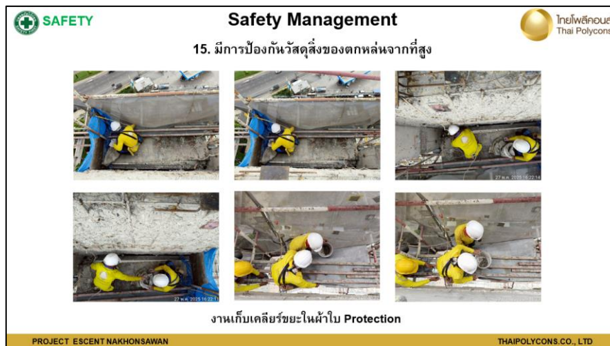
รูปที่ 42 การทำ Protection ป้องกันวัสดุตกหล่น
