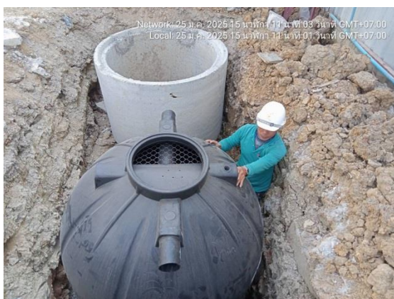
รูปที่ 16 ถังบำบัดน้ำเสียสำเร็จรูป สำหรับรองรับน้ำเสียจาก ห้องน้ำห้องส้วม
